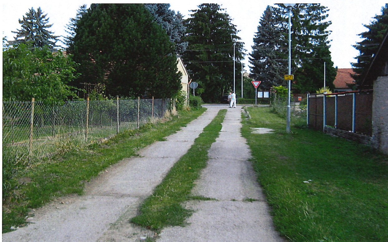
Využití stávající místní komunikace v Kostomlátkách z odpojení z hlavní místní komunikace (km 1,540 – 1,580). Vozovka ze silničních panelů se nahradí vozovkou s asfaltovým povrchem.
